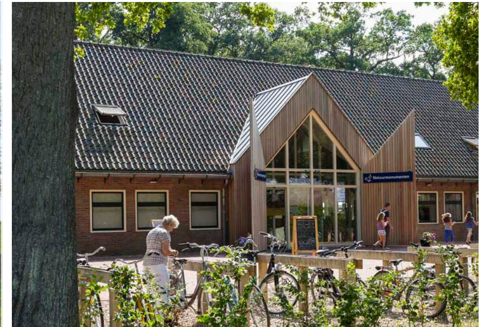
Krachtige ingrepen maken het gebouw toegankelijk en representatief
