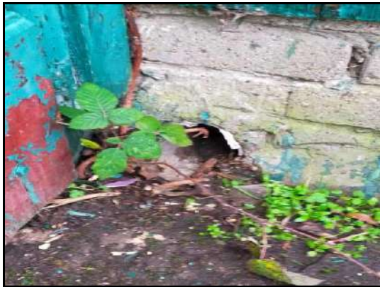
Afbeelding 10: Opening in gevel naar achterliggende ruimte
