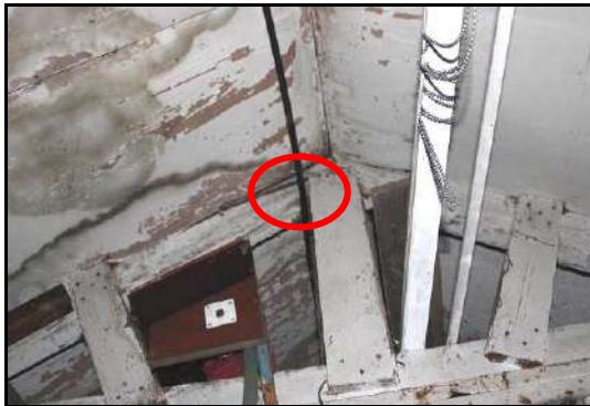
Afbeelding 8: Inpandig ruimte achter houten beplating
