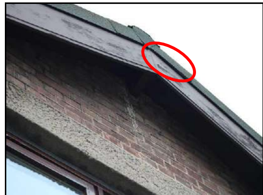
Afbeelding 5: Achter aanhechting dakpannen
