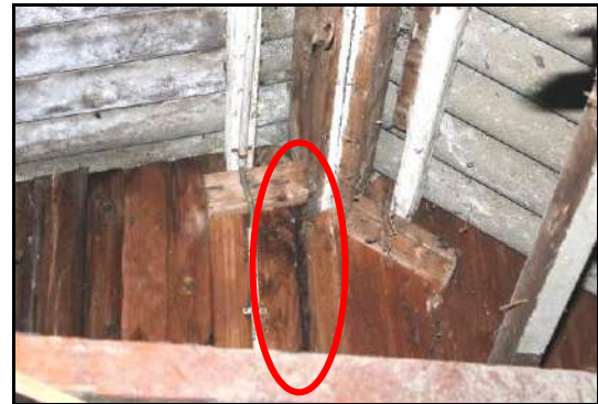
Afbeelding 9: Inpandig ruimte bij plafond
