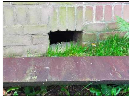
Afbeelding 13: Toegang tot kruipruimte woonhuis
