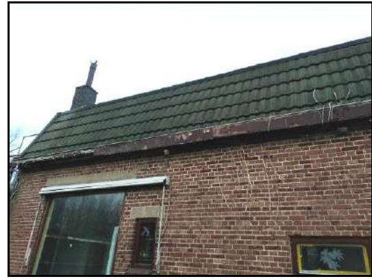
Afbeelding 15: Ruimte onder dakpannen
