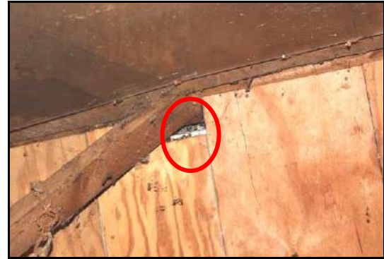
Afbeelding 7: Inpandig ruimte achter houten beplating
