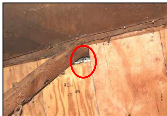
Afbeelding 7: Inpandig ruimte achter houten beplating
