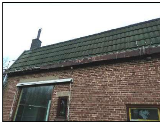
Afbeelding 15: Ruimte onder dakpannen
