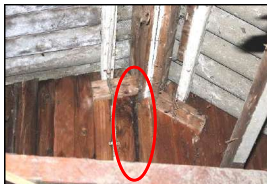
Afbeelding 9: Inpandig ruimte bij plafond
