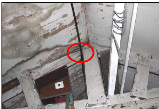
Afbeelding 8: Inpandig ruimte achter houten beplating
