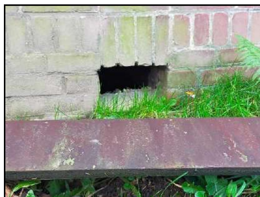
Afbeelding 13: Toegang tot kruipruimte woonhuis
