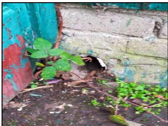
Afbeelding 10: Opening in gevel naar achterliggende ruimte
